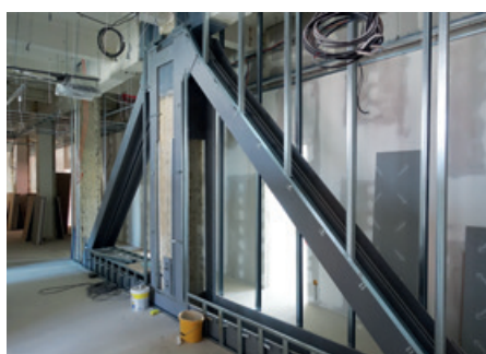
18. 5. 2020 Konstrukce nahrazující sloup
