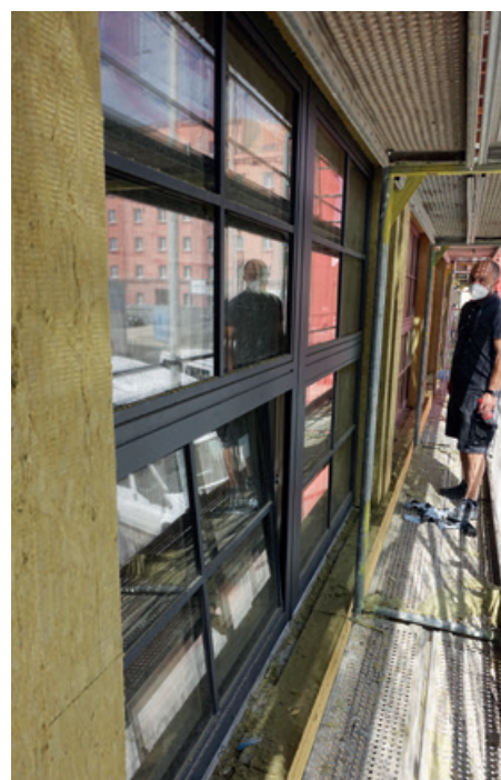
18. 5. 2020 Zateplení fasády a nová okna
