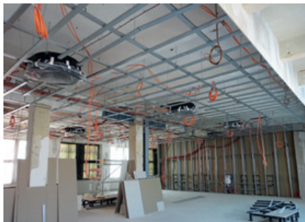
18. 5. 2020 Elektrické rozvody a klimatizace
