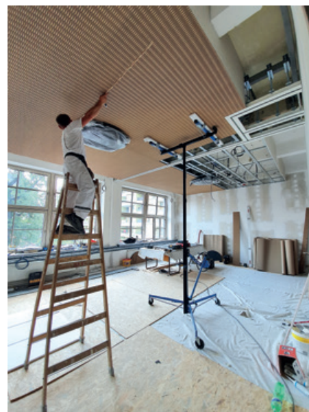
10. 8. 2020 Montáž akustických obkládů
